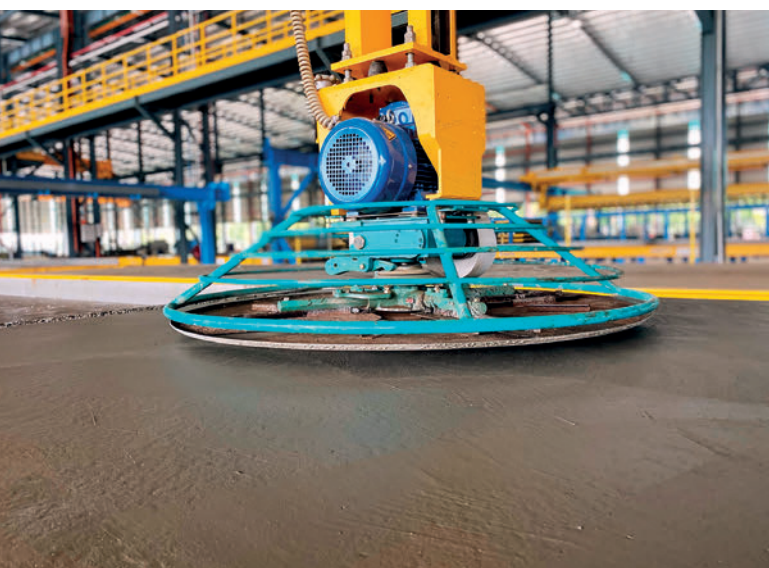
Mühelose Fertigstellung: Der Flügelglätter erzeugt gleichmäßige Oberflächen, so dass ein Anstrich nicht mehr erforderlich ist
