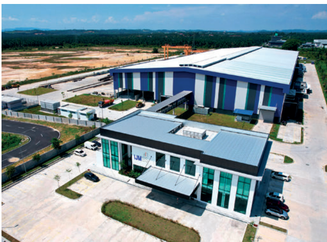
IJM IBS stellt mit den automatisierten Maschinen der Progress Group in Bestari Jaya, Selangor, Malaysia, fortschrittliche Betonfertigteile her
