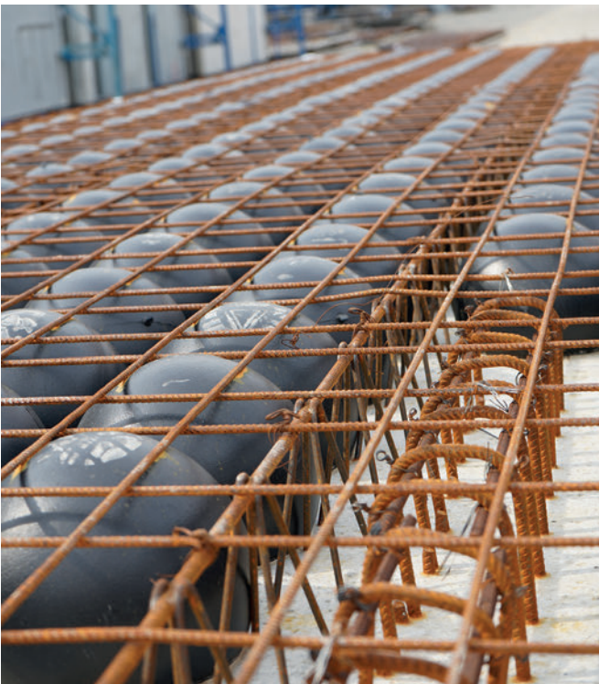
Eines der wichtigsten und meistverkauften Produkte von IJM ist die Bubbledeck-Platte
