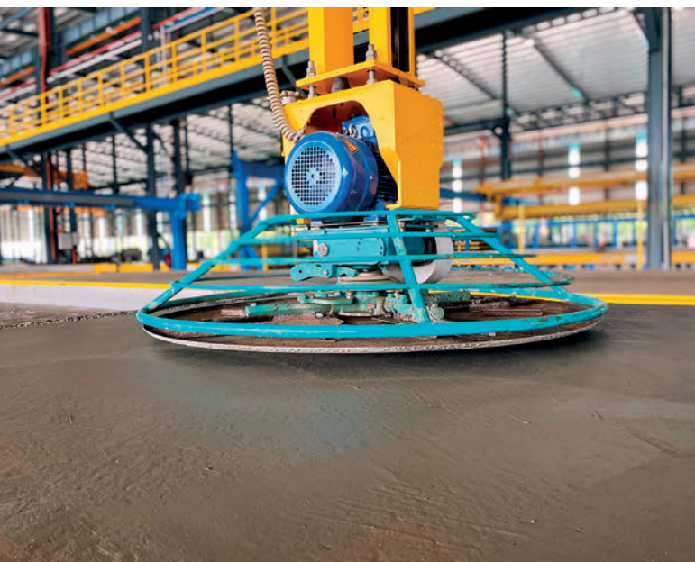
Finitura senza fatica: la lisciatrice realizza superfici omogenee per cui non occorre più la tinteggiatura.
