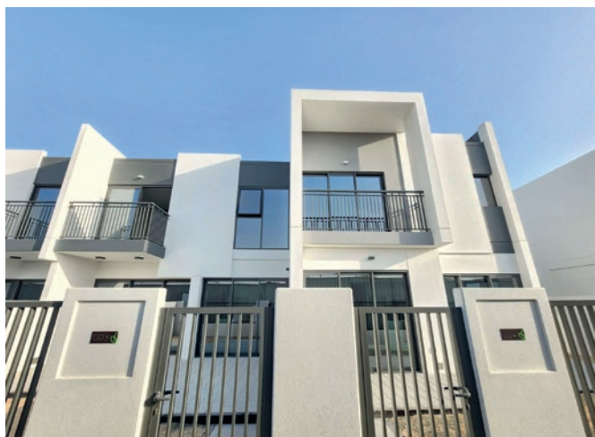
Villa Nova La Rosa, un progetto realizzato con pareti prefabbricate in calcestruzzo.
