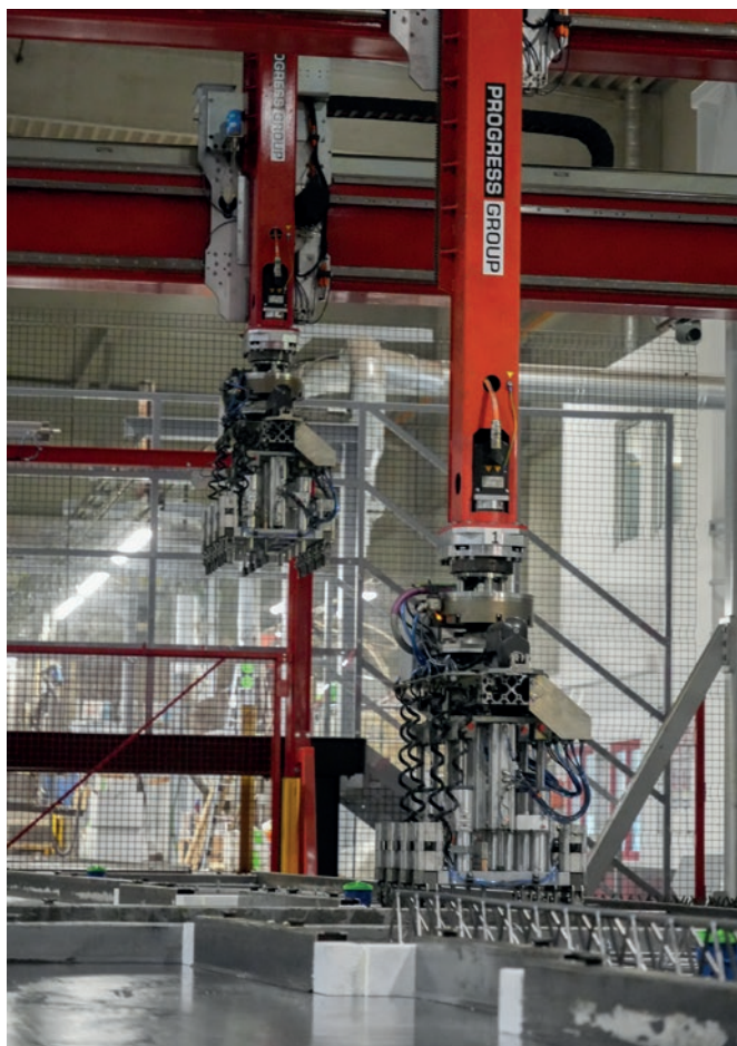
Im Wire Center wird Betonstahl vollautomatisch vom Coil bearbeitet und verlegt.
