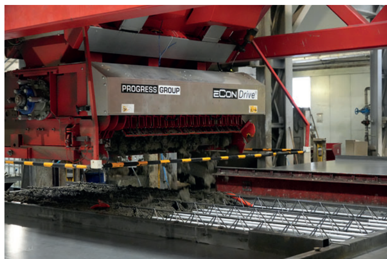
Бетонораспределитель обеспечивает равномерную и точную разгрузку бетона в опалубку поддонов на производственной линии
