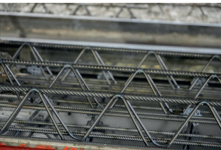
Особенность машины: решетчатые балки с разным диаметром проволоки для верхнего и нижнего пояса
