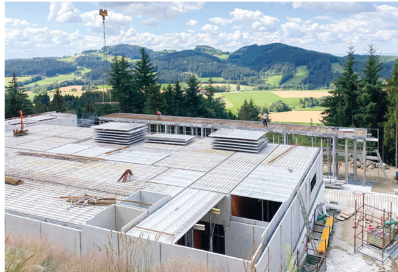
La locanda di montagna nel parco divertimenti Edelwies, nella foresta bavarese, è in corso di costruzione con gli elementi prefabbricati provenienti dal nuovo stabilimento.
