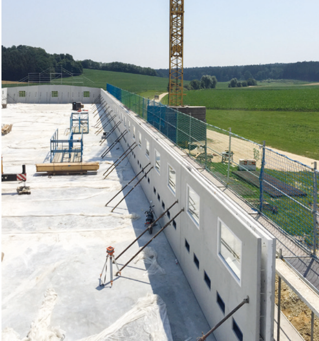
Le pareti termiche sono utilizzate anche nell'edilizia agricola, come qui per un pollaio.
