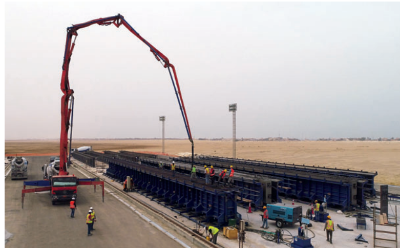
Mit den Formen können Elemente mit Längen von 40 bis 45,5 m hergestellt werden, die auf die geforderte Größe angepasst werden können.
