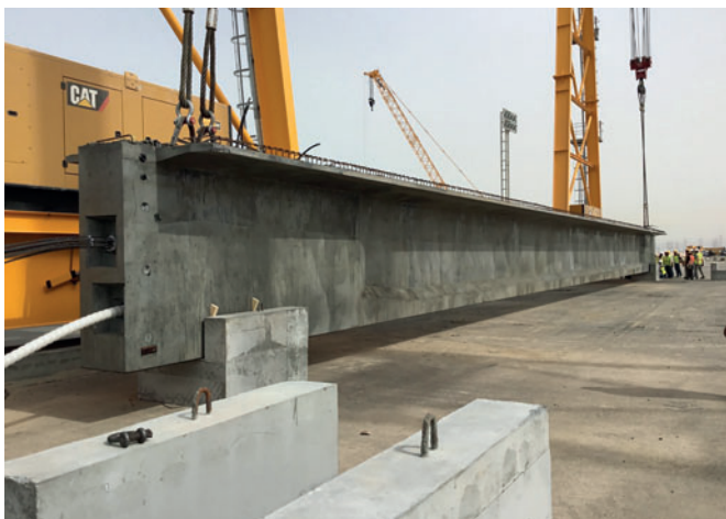
Die Elemente werden (mit nachträglichem Verbund) vorgespannt. Täglich können acht Elemente hergestellt werden. Für alle Brücken sind insgesamt 820 Träger erforderlich.
