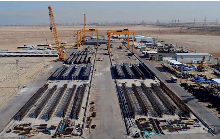
9 der Brücken werden mit Betonfertigteilen gebaut, die mit Formen von Tecnom in einer lokalen Produktionsstätte hergestellt werden.
